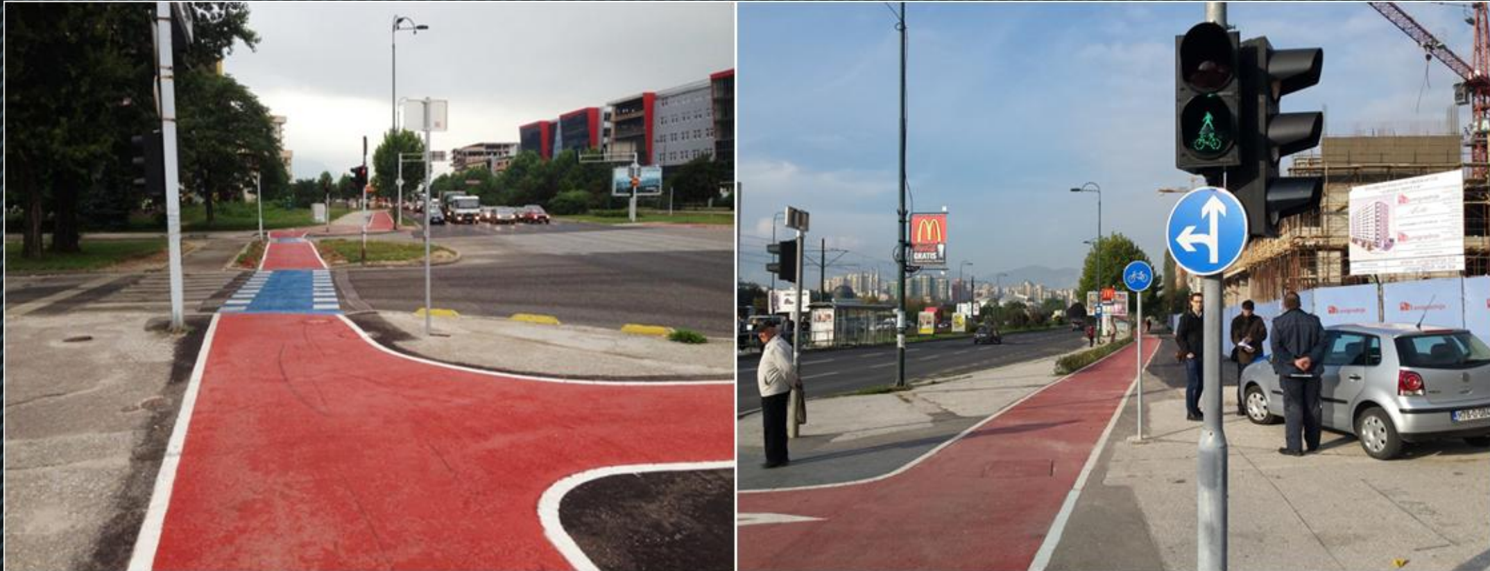
Slika 4. Izgrađena biciklistička staza, dionica Otoka - Nedžarići
